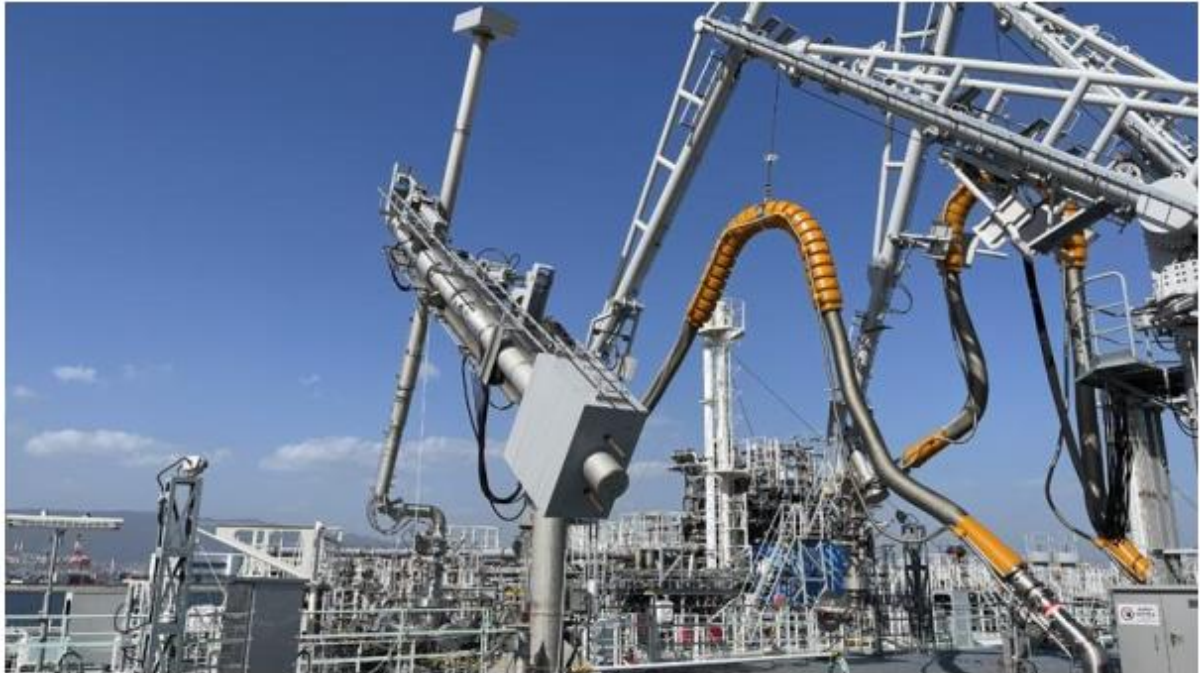
Hình 22: Một hệ thống cần trục bốc hàng cố định từ tàu vào bờ (LAS) được lắp đặt trong bến cảng hydro tại cảng Kobe, Nhật Bản. Nguồn: HySTRA.
