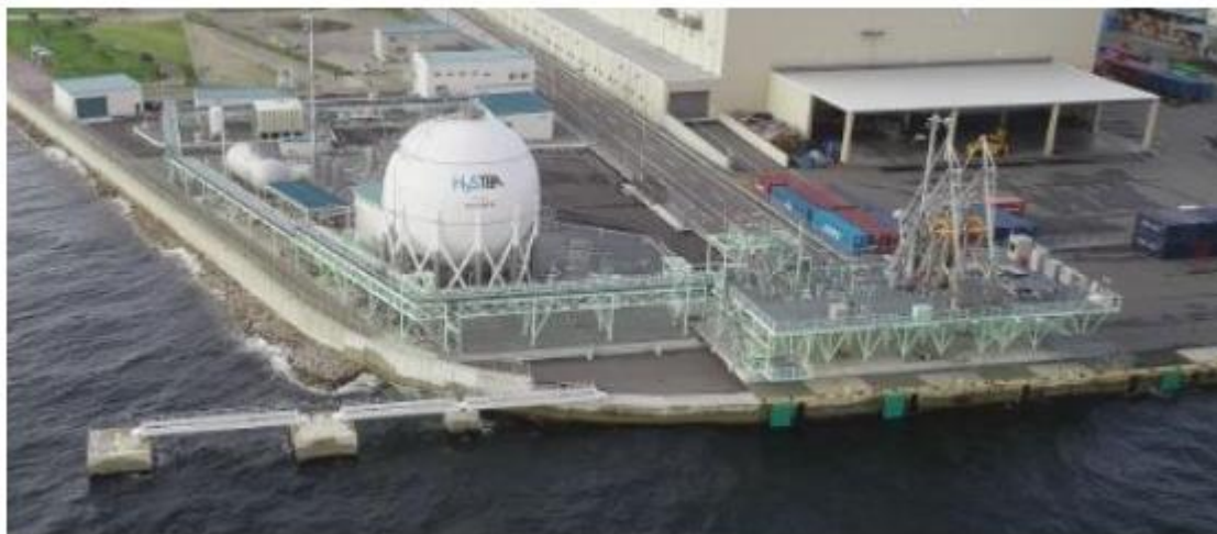
Hình 23: Bồn chứa hydro lỏng lớn thứ ba thế giới là một phần của bến cảng nhập khẩu tại Cảng Kobe, Nhật Bản và có thể chứa 178 tấn 68 (ảnh: HyTouch Kobe).
